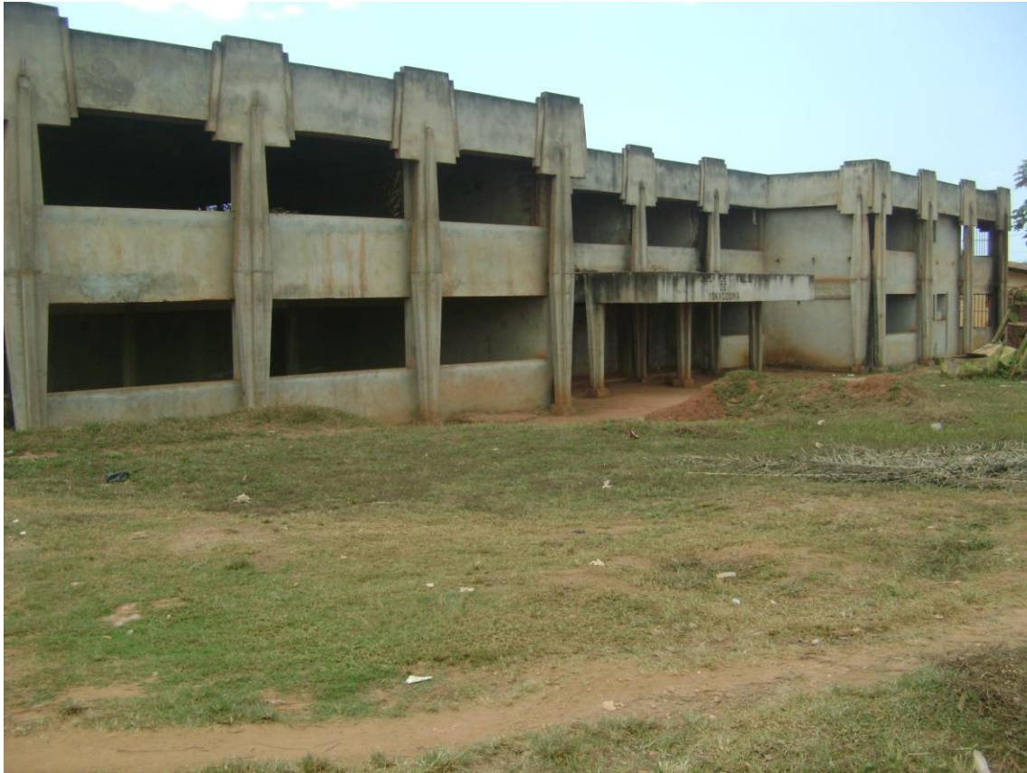
Bâtiment inachevé de l'hôtel de Ville – Yokadouma
